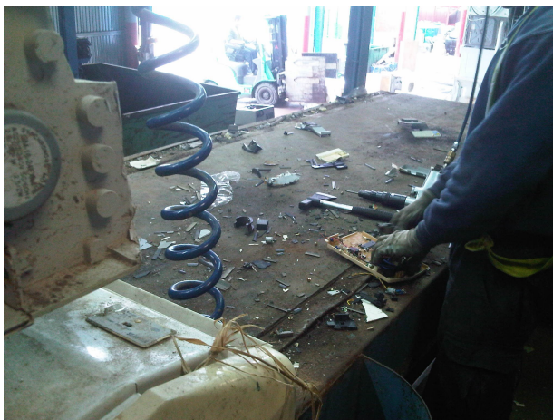
Imagen 3: Desmontaje manual en la planta de Ca Na Negreta
